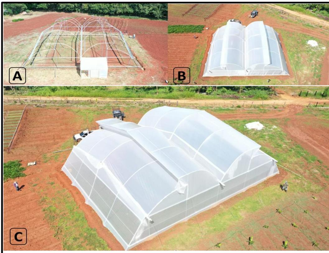
Vista panorámica del prototipo multitúnel asimétrico, A) Estructura metálica B) Cobertura anti térmica y malla anti insecto 40 mesh C) Perfil lateral orientado en dirección a vientos predominantes (noreste). Estación Experimental El Ejido, provincia de Los Santos, Panamá.
