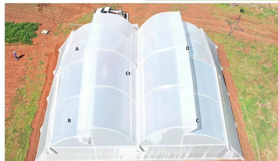
Distribución de los sensores Spectrum-Campbell™, instalados en el prototipo multitúnel asimétrico.
